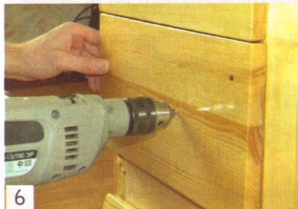
Рис. 1-2 Места сверлений отверстий в боковинах пеналов
